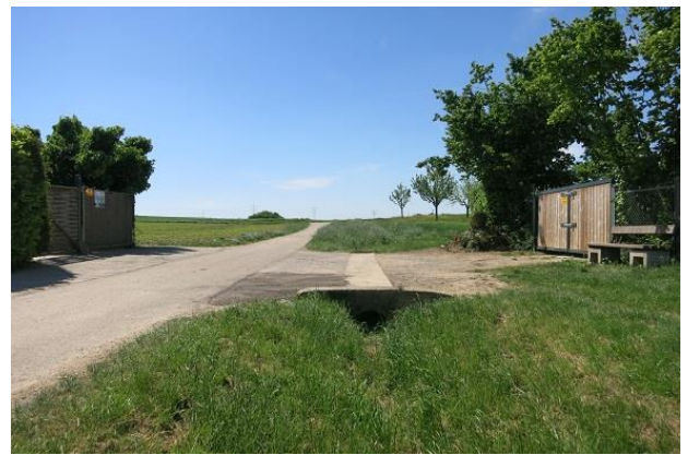
Abbildung 44: Verdolung im Bereich einer Zufahrt (Blick bachaufwärts)
