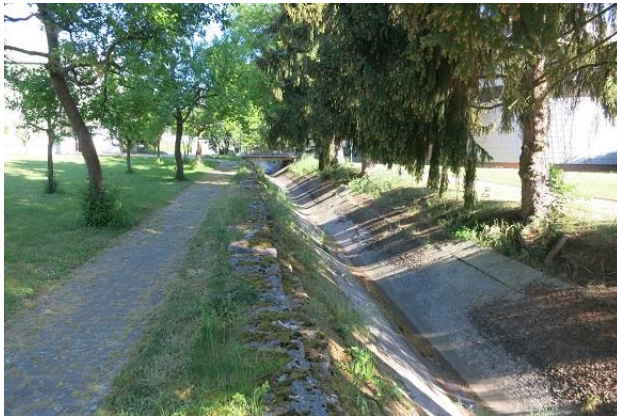
Abbildung 12: Geradliniger Verlauf des Gerinnes im Bereich der Kläranlage (Blick gegen Fließrichtung)
