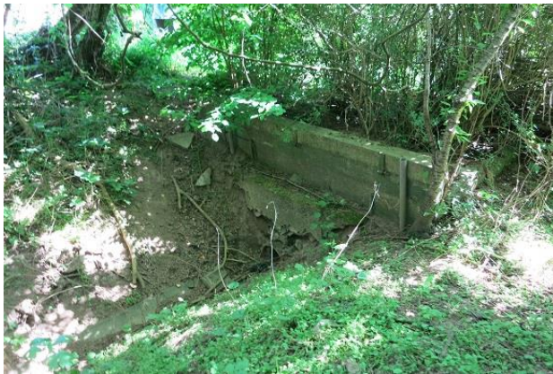
Abbildung 23: Durchlass am oberen Abschnitts- ende des Mussenbachs
