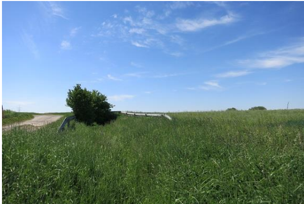
Abbildung 46: Auslauf auf der Verdolungsstrecke (Blick talaufwärts)
