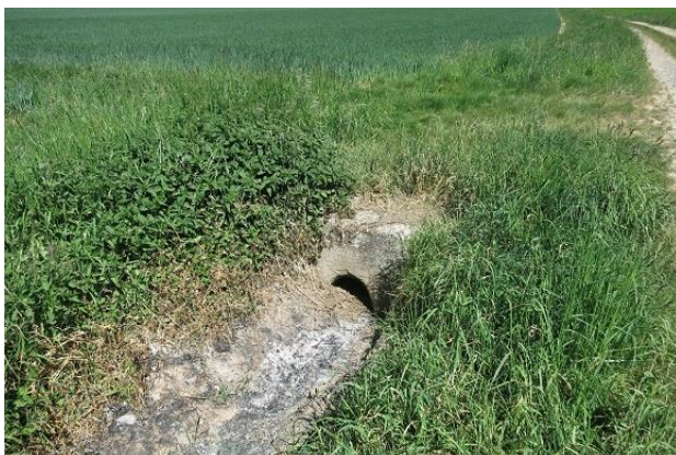
Abbildung 45: Verlandeter Rohrdurchlass
