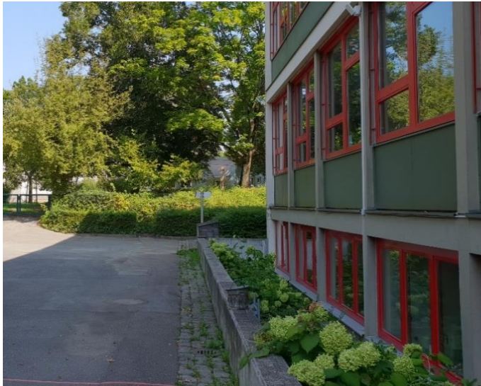
Abbildung 5: Die im Jahr 2010 erstellte Schutzmauer vor dem Schulgebäude
