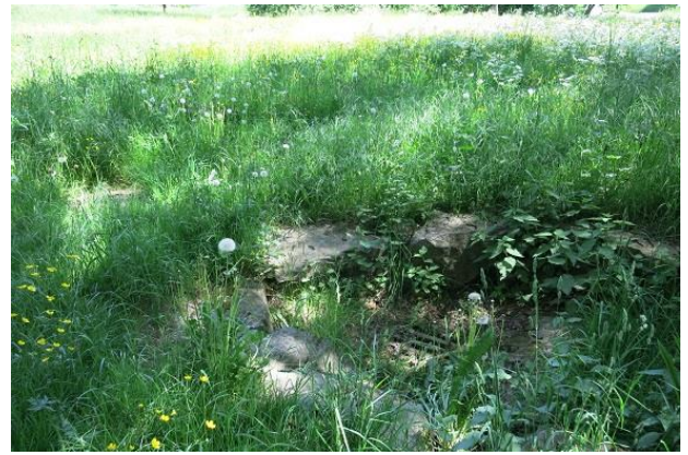
Abbildung 37: Einlauf in den Mischwasserkanal
