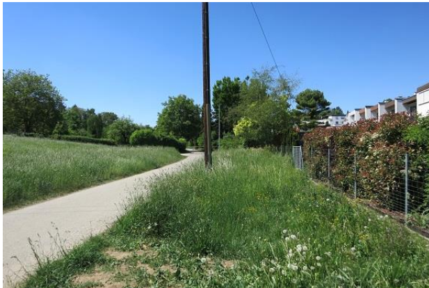
Abbildung 34: Kanal im Grünstreifen zwischen Weg und Privatgärten (Blick talaufwärts)
