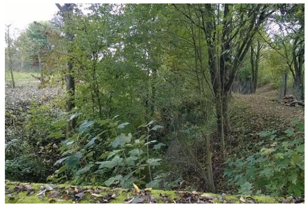
Abbildung 16: Offen verlaufender Mischwassersammler (Blick in Fließrichtung)
