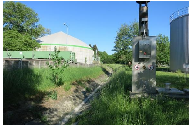
Abbildung 13: Betoniertes Gerinne zwischen Biogasanlage und Grünland (Blick gegen Fließrichtung)
