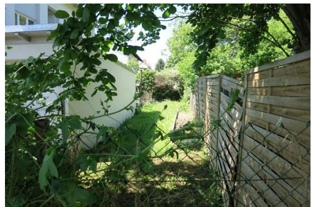
Abbildung 39: Verdolung oberhalb der Mühlhäuser Straße (Blick talaufwärts)
