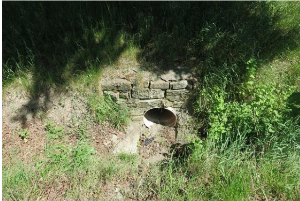
Abbildung 32: Einlauf in die Verdolung im Bereich der Ludwigsburger Straße
